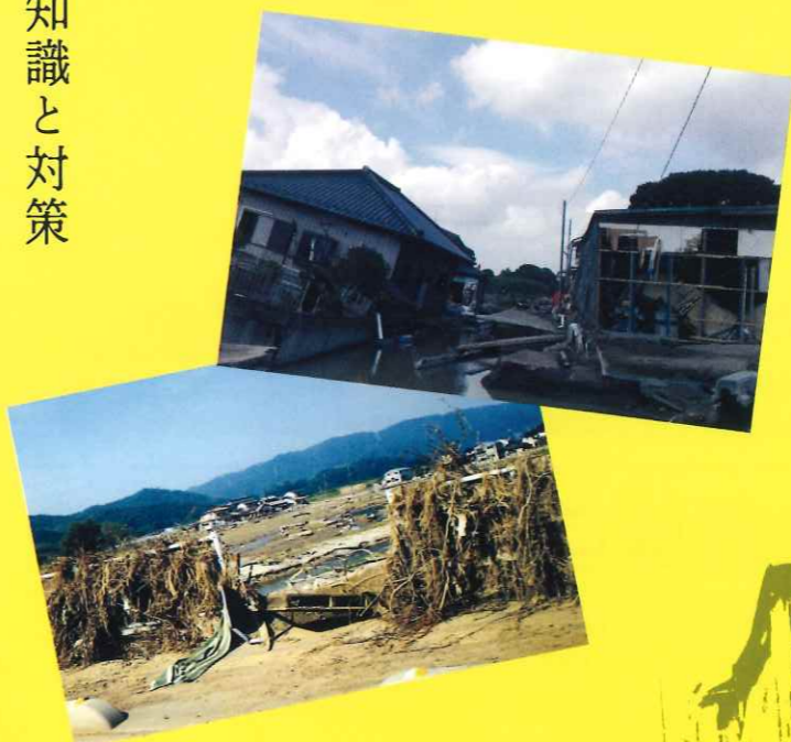
写真上:2015年9月 東北豪雨・鬼怒川氾濫(写真撮影:和田隆昌) 写真下:2018年7月 西日本豪雨・岡山県真備町(写真撮影:和田隆昌)
